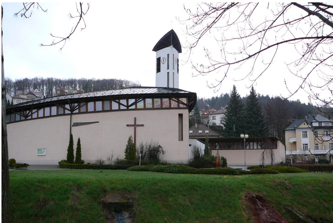
Obr. 11: Farní kostel Svaté Rodiny v Luhačovicích postavený v 90. letech 20. století
